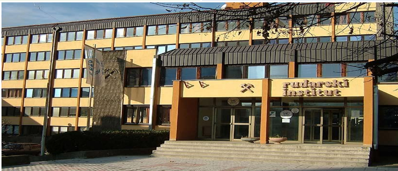
Sadašnja zgrada Rudarskog instituta izgrađena 1984. / Present building of the Mining Institute, built in 1984.
