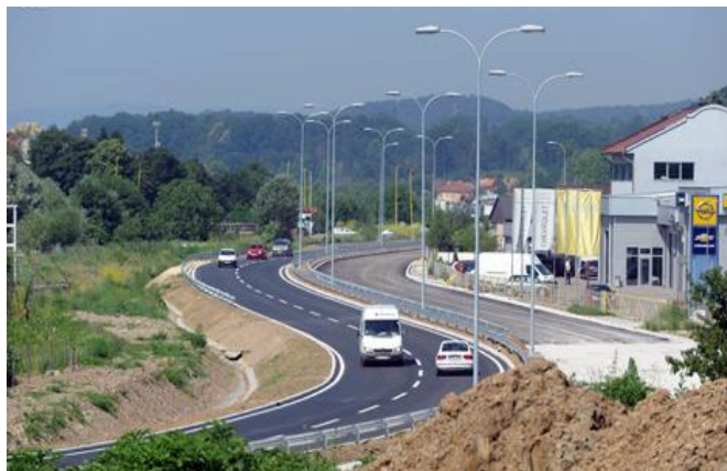
Geotehnička misija G21 za projekat izgradnje kolovoza na cesti M4, dionica "Tuzla-Šiški Brod" / Geotechnical mission G21 for construction of the road M4, section "Tuzla-Šiški Brod"
