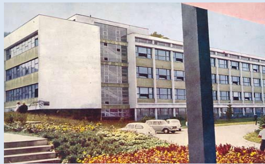
Zgrada Instituta za rudarska i hemijsko-tehnološka istraživanja u Miladijama, Tuzla (1965) / The Mining and Chemical -Technological Research Institute in Miladije, Tuzla (1965)
